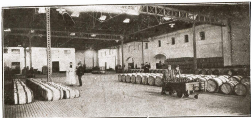
HALL D'EXPÉDITION DES VINS DE LA SOCIÉTÉ IMMOBILIÈRE ET AGRICOLE DE L'HARRACH A MAISON-CARRÉE (ALGER)
